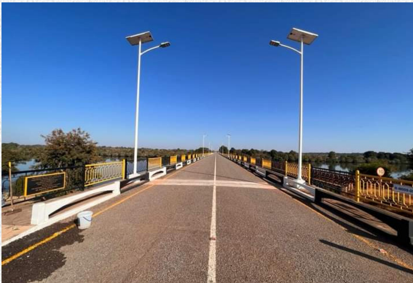
Rehabilitated Kafue Hook Bridge.
