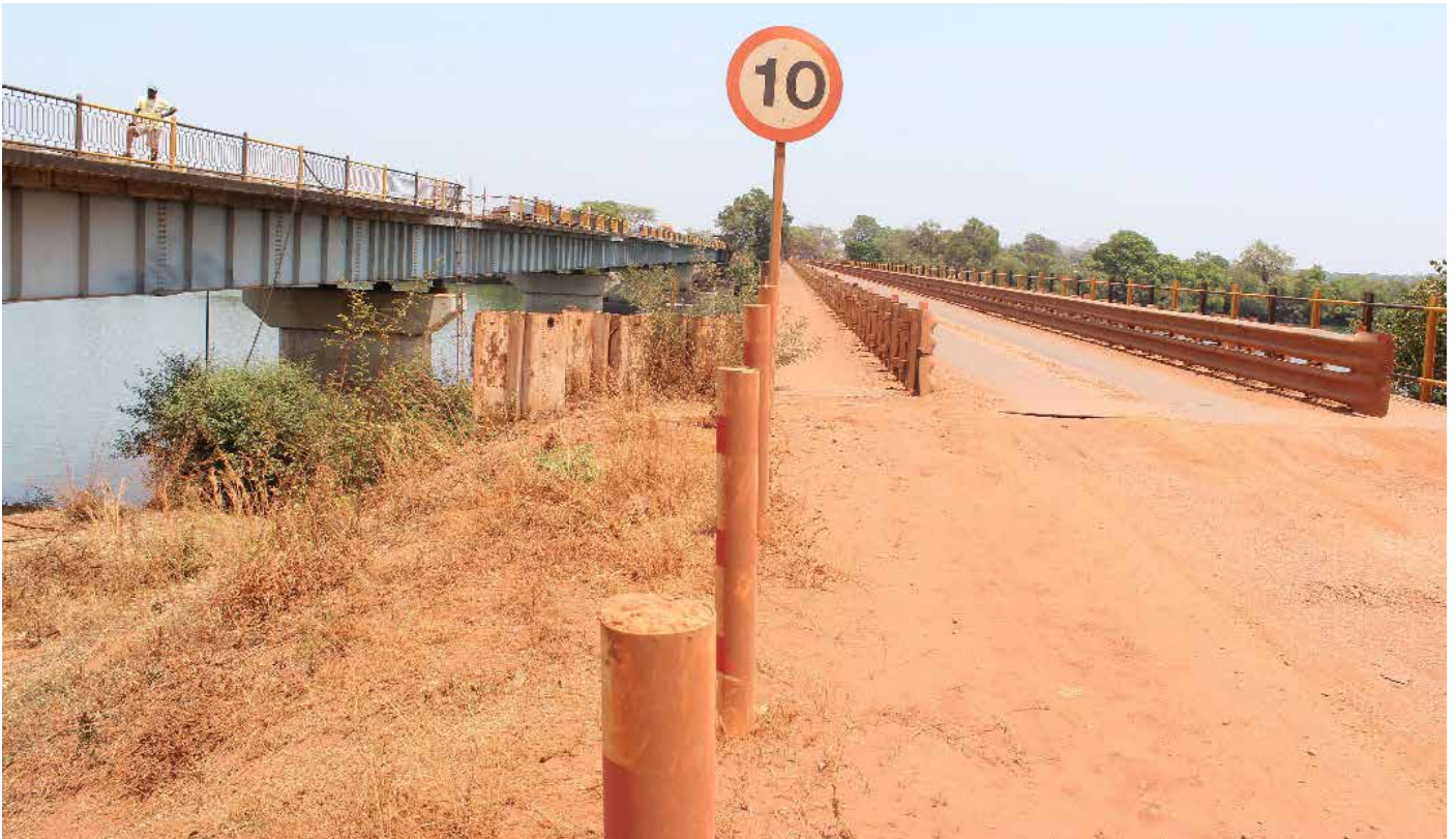
Figure 3: Kafue Hook Bridge
