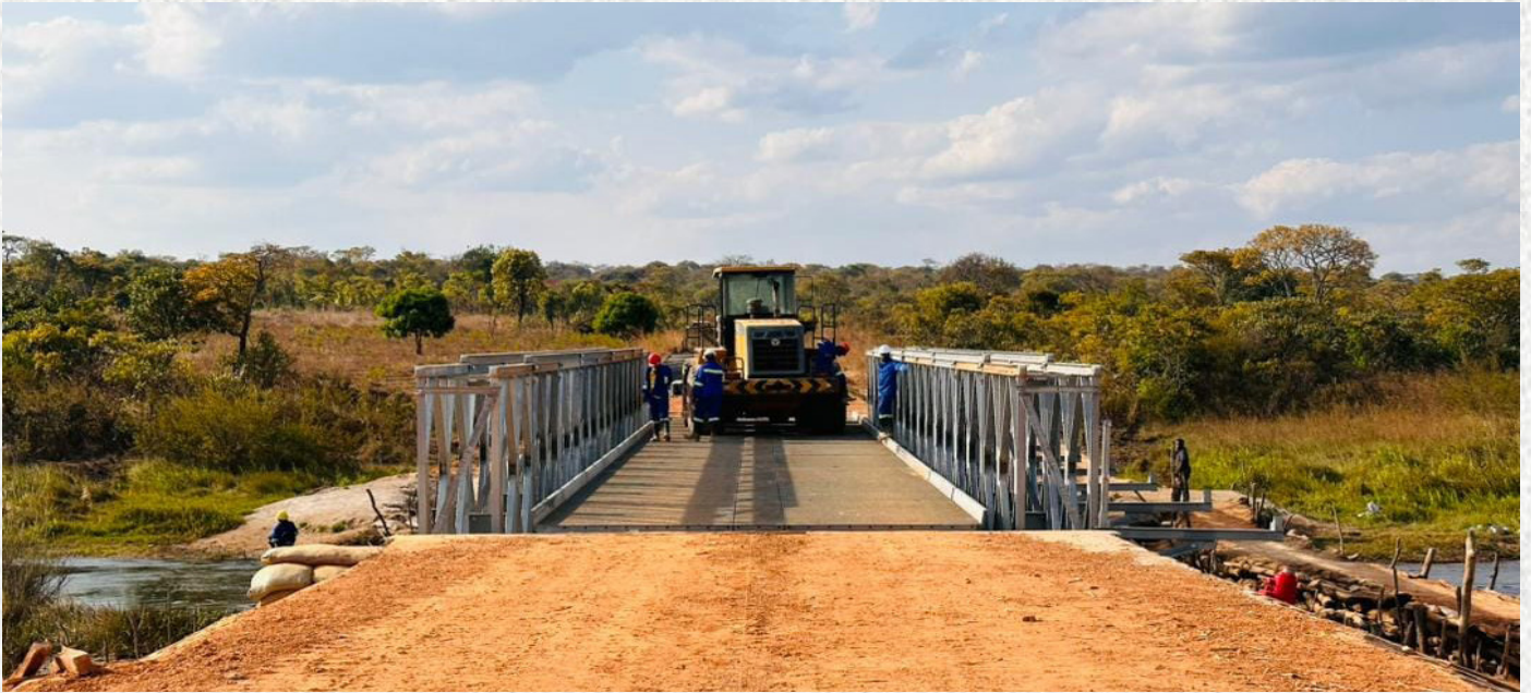
Lukulu ACROW Bridge.
